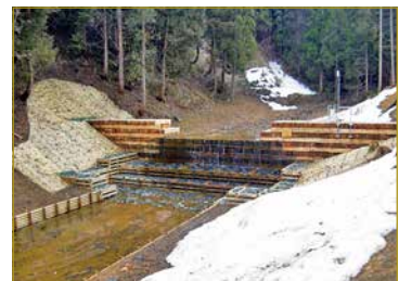
木製治山ダム工（オールウッド型）
