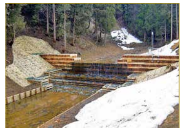
木製治山ダム工（オールウッド型）
