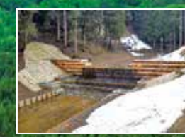
木製治山ダム工(オールウッド型)
