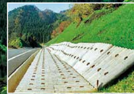
コロット丸太伏工
