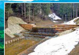
木製治山ダム工(オールウッド型)
