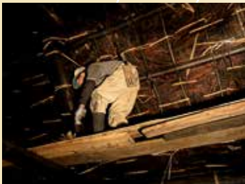
屋根裏での作業も足取り軽やかな村上さん。屋内とはいえ高所作業だ。
