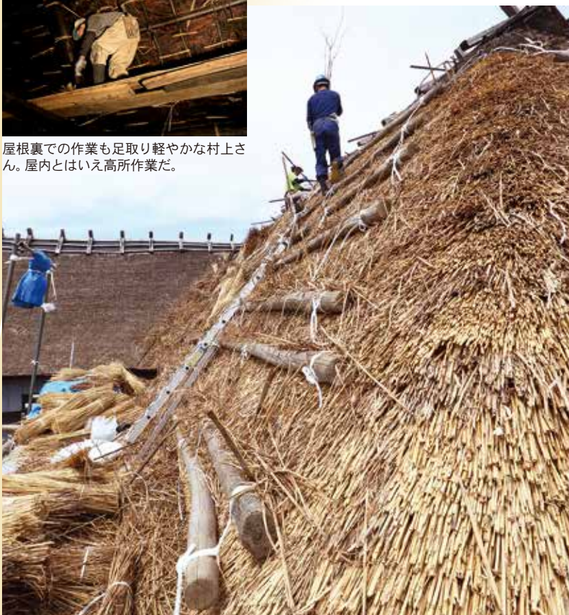
茅の葺き替えは、足場を組んだり、茅を積み上げたり力仕事。一定範囲を「差し茅」と呼ばれる手法で葺き直し、何年もかけて一周します。奥に見える屋根は6年前に直した箇所。
